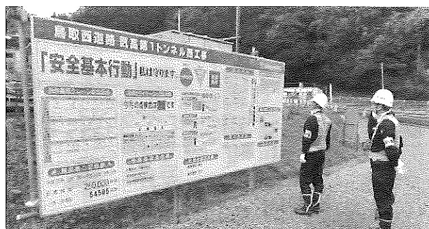
安全パトロールの様子
