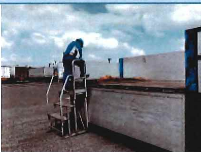
墜落・転落防止：昇降台の導入
